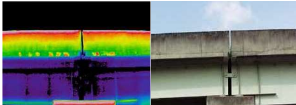
構造物診断(橋梁)
